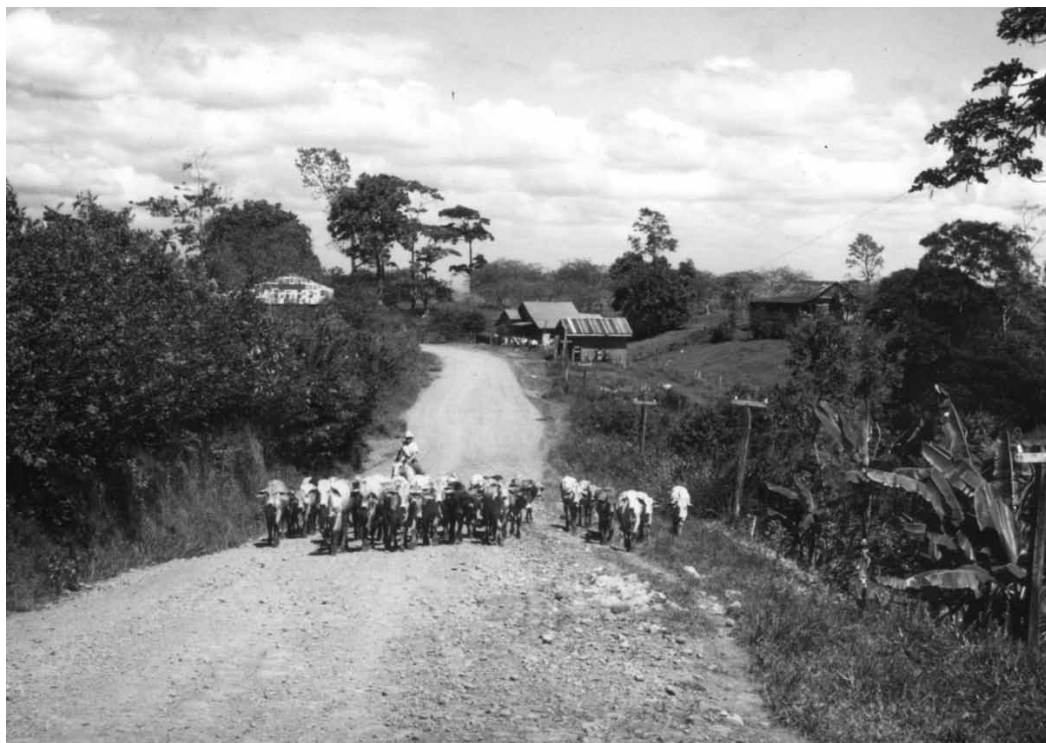
Ryc. 4.1. Erozja drogi i procesy transportu rumowiska związane z jej wykorzystaniem przez zwierzęta i pojazdy w zestawieniu z wiatrem i spływami wody. Środkowa Nikaragua. Zdjęcie: R.T.T. Forman.
