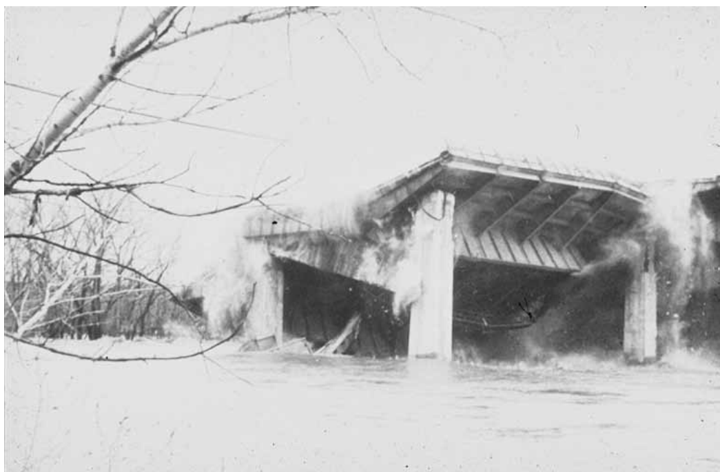
Ryc. 4.5. Zawalenie się mostu spowodowane wymywaniem koryta rzeki podczas powodzi. Wielopasmowa autostrada międzystanowa nr 90 na rzece Schoharie Greek, Fort Hunter, Nowy Jork, 1987. Zdjęcie udostępnione dzięki uprzejmości D.S. Mueller, Sidney Brown oraz U.S. Geological Survey.
